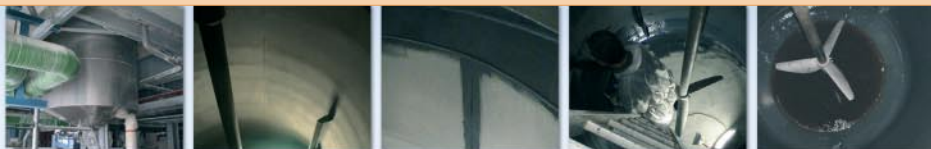
Mekanisk borttagning av rostfläckar och uttorkade invändiga ytor Sandblästar till en ytprofil av 75 µm och ytrenhet på SA 3 Applicera Loctite® Nordbak® 7227 på svetsfogarna Hela ytan belades och efter delvis härdning lades ett andra lager Efter 24 timmar var tanken redo att fyllas
