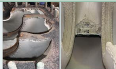
Kaviteter och erosion var tydligt
